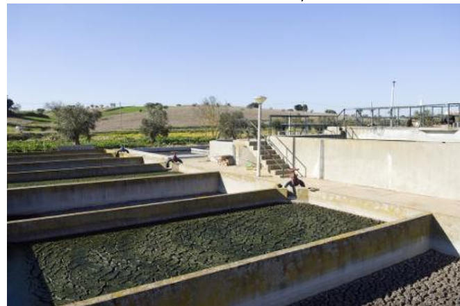
Tanque cheio de lodo proveniente do esgoto
