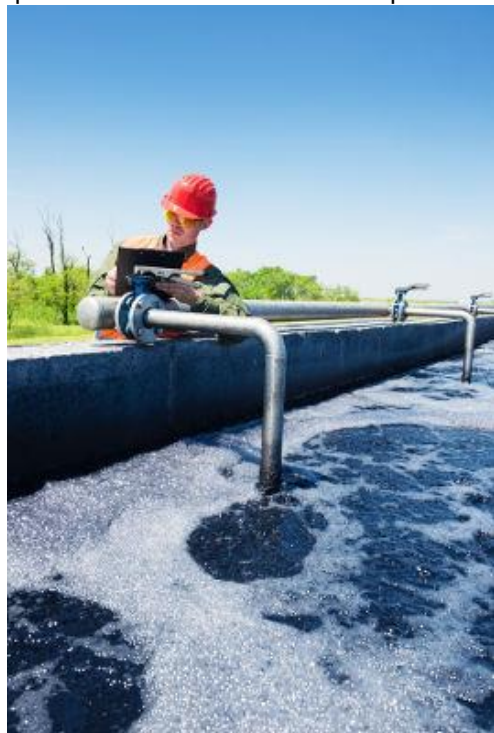
Esgoto recebendo ar no tanque de aeração
