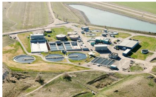
Foto panorâmica de uma estação de tratamento de esgoto Por Diogo Lopes Dias
