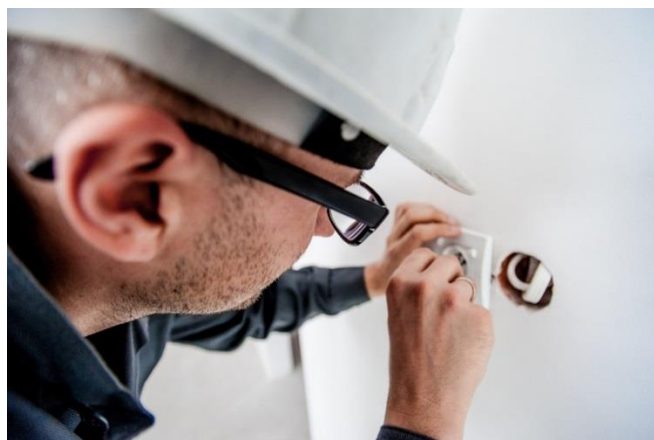
Manutenção da instalação
